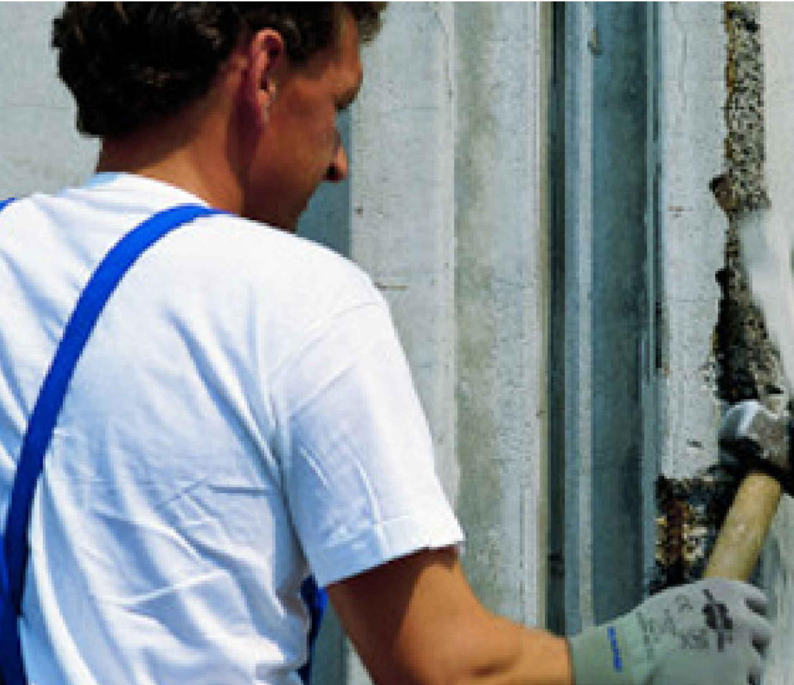
1 e 2 RIMOZIONE COPRIFERRO AMMALORATO
